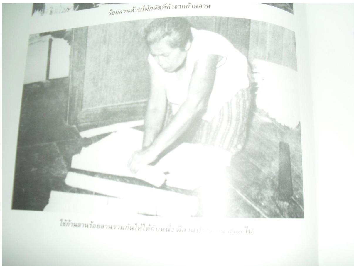
ภาพที่ ๗ การใช้ก้านลานร้อยลานรวมกันให้ได้กับหนึ่ง มีลานประมาณ ๕๐๐ ใบ
